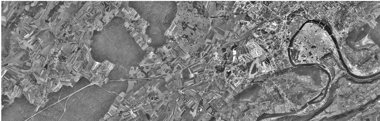
Figure 3. Exemple de photographie aérienne de 1956 dans la zone d'étude (extrait)
