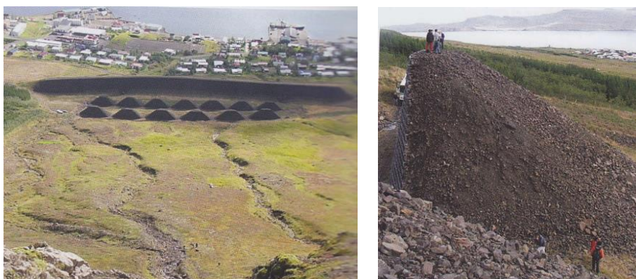
Photo 3 : Digue d'arrêt (17m de haut et 260m de long) et tas freineurs (11m de haut) en Islande / © T. Faug Irstea
